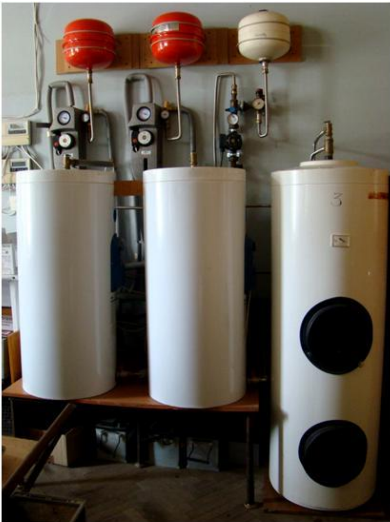
Накопичувальні баки сонячних колекторів, встановлені в лабораторії № 429
